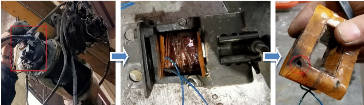
Рис. 25. Демонтаж поврежденной катушки с электродвигателя лебедки тельфера ТЭ-0,5
